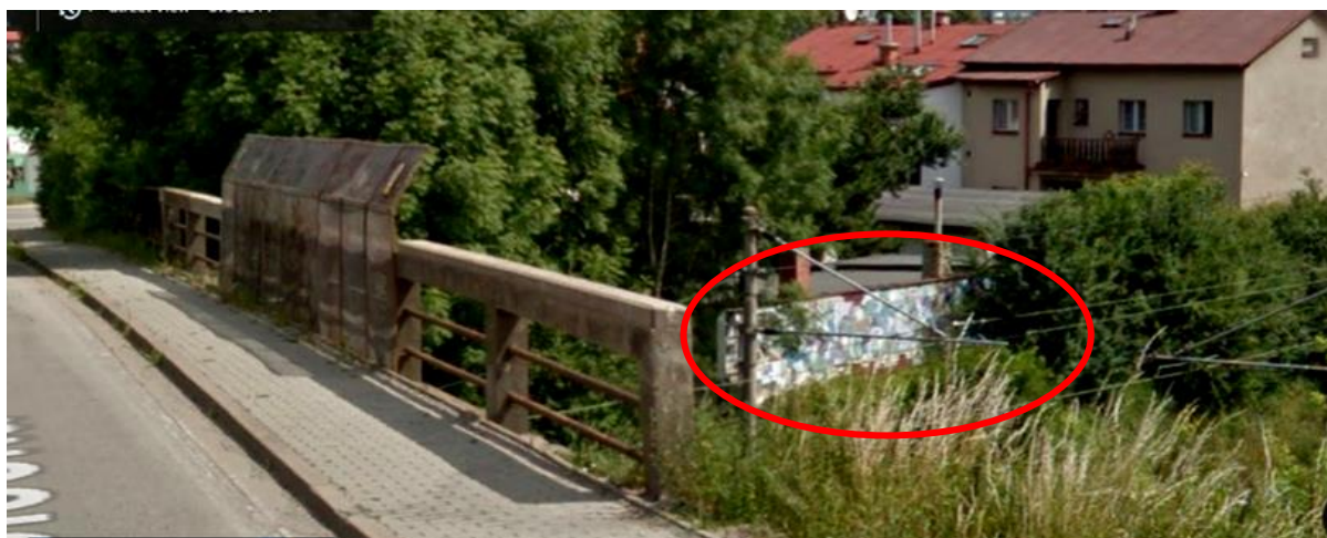
Obr.č.23 Pohled na rodinný dům č.p. 1507 – rok 2011/2012 – pohled na fasádu otočenou k trati (bez oken, jednopodlažní objekt) (zdroj: www.google.cz/maps )
