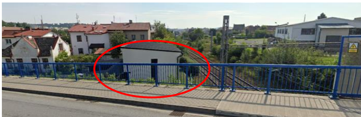
Obr.č.25 Pohled na rodinný dům č.p. 1507 – rok 2019 (zdroj: www.google.cz/maps)
