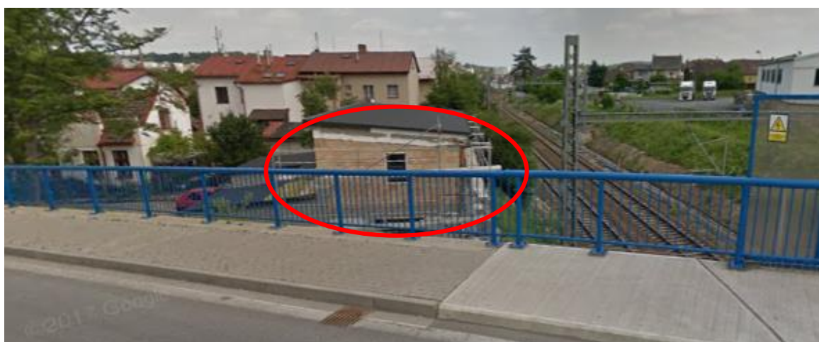
Obr.č.24 Pohled na rodinný dům č.p. 1507 – rok 2017 (zdroj: www.google.cz/maps )
